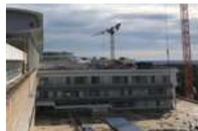
Surélévation de Carêmeau Sud
