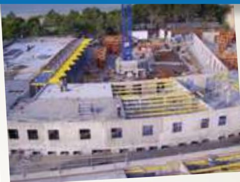
L'Hôpital du Grau-du-Roi en construction
