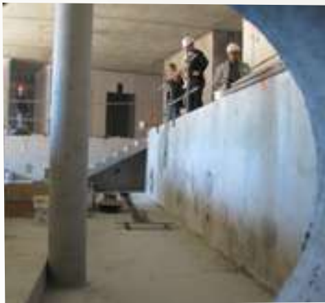
Visite de chantier
