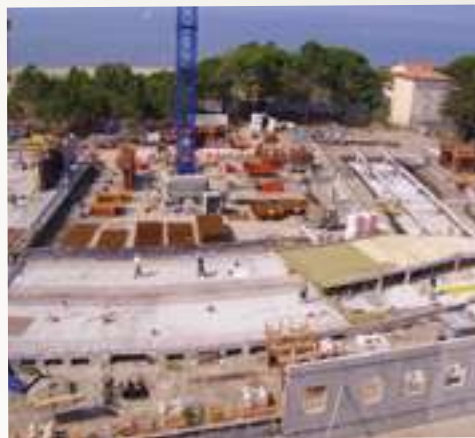
L'Hôpital du Grau-du-Roi en construction
